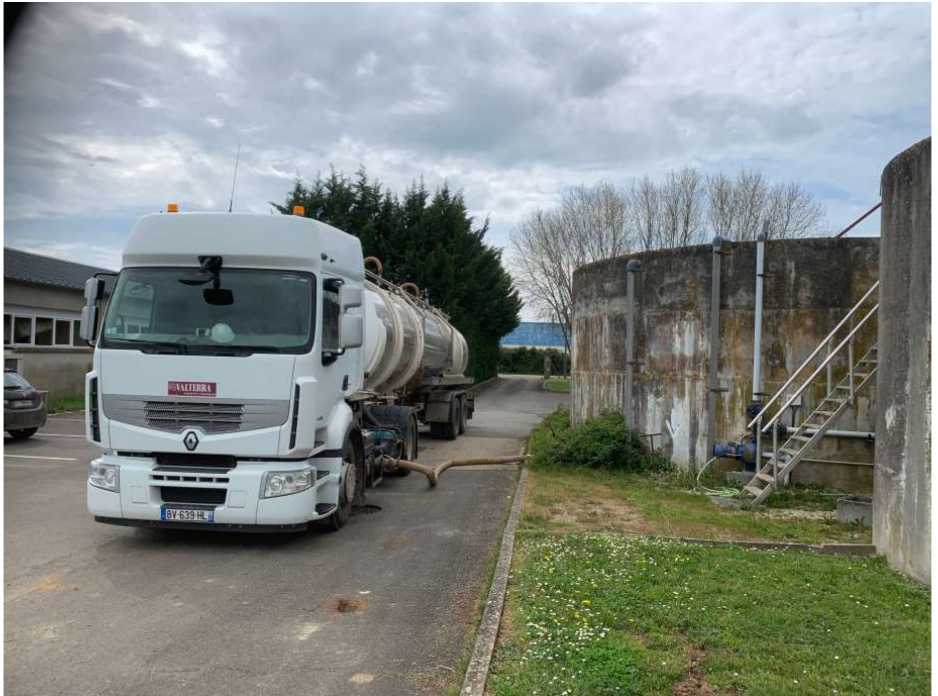
Alimentation par la vanne de vidange du silo
