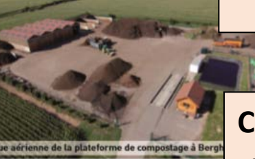
Vue aérienne de la plateforme de compostage à Bergheim
