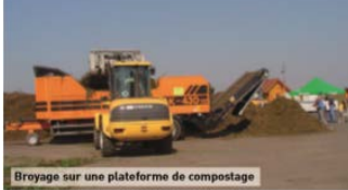
Broyage sur une plateforme de compostage
